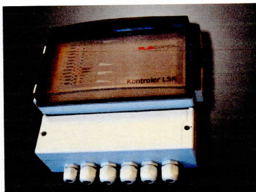
Fot. 9 – Sterowniki urządzeń przeciwpożarowych (np. typu LSK przeznaczonych do sterowania cyfrowych siłowników przeciwpożarowych kłap odcinających)
