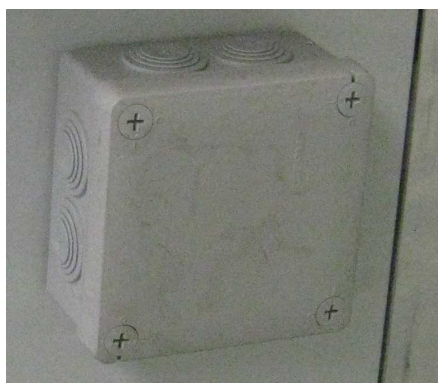
Rys. 12.6. Punkt pomiaru ciśnienia statycznego (wersja naścienna).
